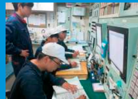
えひめ丸機関監視
